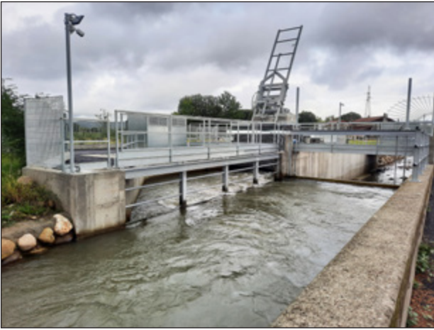
Opera di derivazione e presa.
