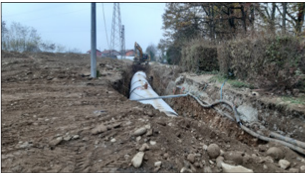
Secondo tratto del canale: posa tubo di derivazione sotto la strada
