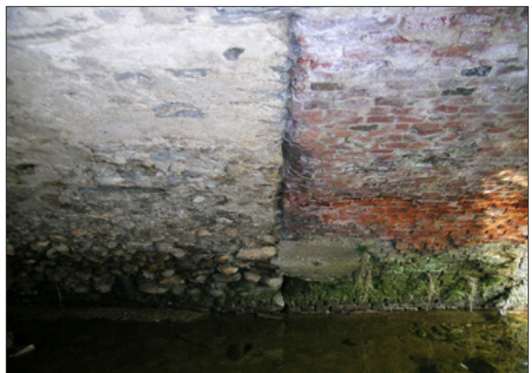
Il punto di giuntura fra il ponte medievale e quello ottocentesco.
