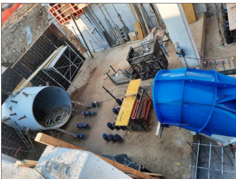
Montaggio diffusore in centrale.
