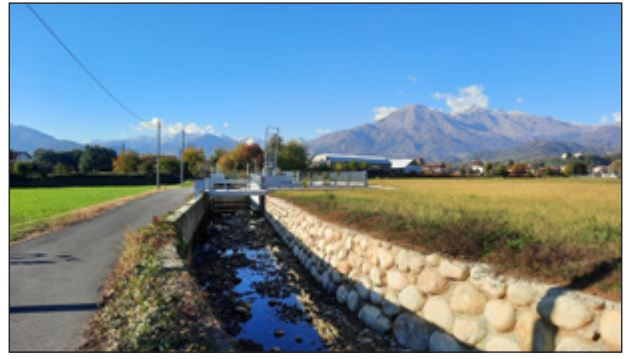
Nuova opera di presa, rifacimento sponda sinistra del canale in ciottoli cementati e pavimentazione strada.
