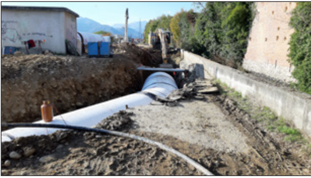
Posa tubo di derivazione sotto la strada in corrispondenza della cabina elettrica e ripristino strada.
