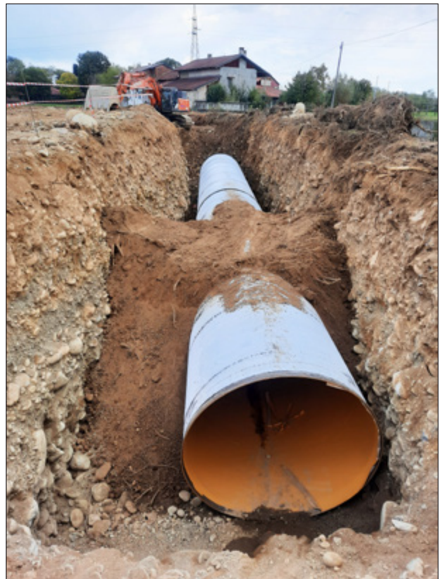
Posa condotta di derivazione.
