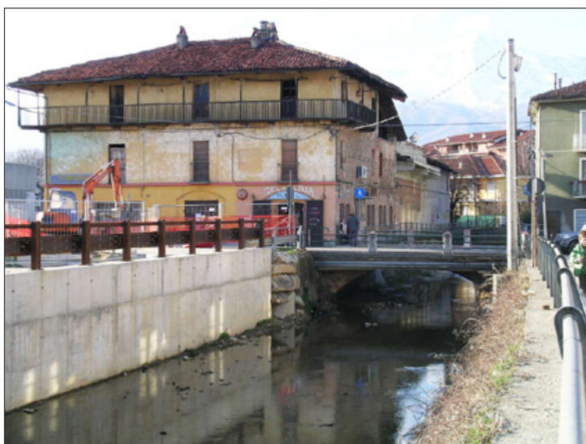
Il ponte sul Rio San Pietro poco prima del suo abbattimento.
