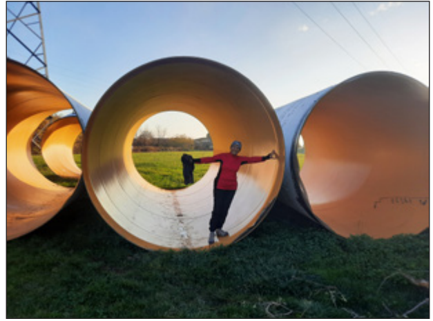
Tubazioni per la condotta di derivazione.
