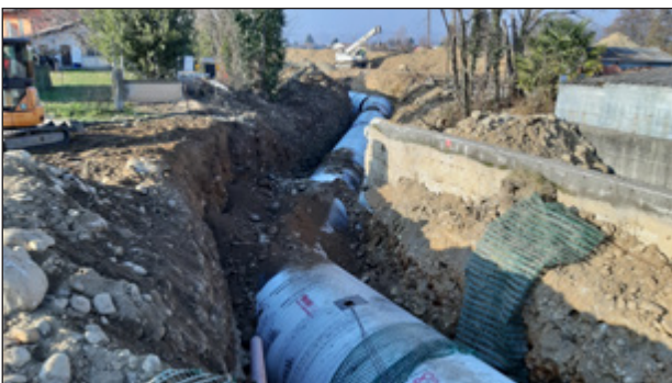
Sottopasso del tubo di derivazione sotto il canale e rifacimento muri del canale.
