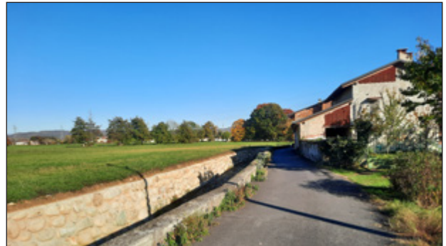
Primo tratto del canale: posa tubo di derivazione in sponda sinistra, rifacimento sponda sinistra del canale in ciottoli cementati e pavimentazione della strada.
