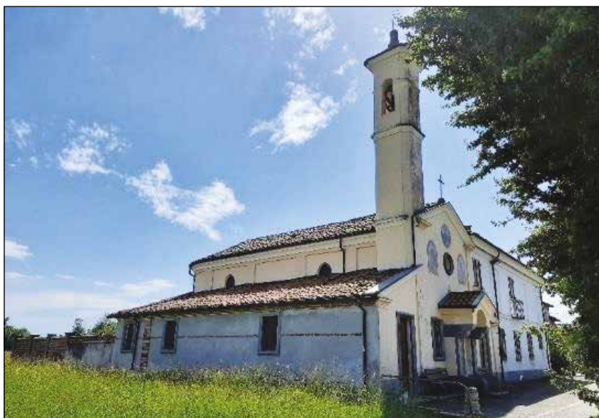
Vista esterno chiesa lato Nord-Est.
