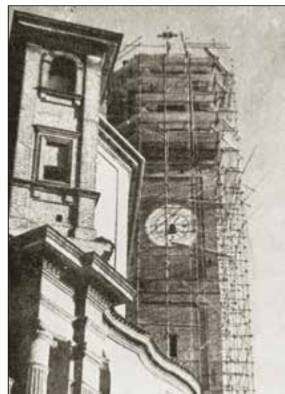
I cantieri per la posa dell'orologio ed elettrificazione campane.
