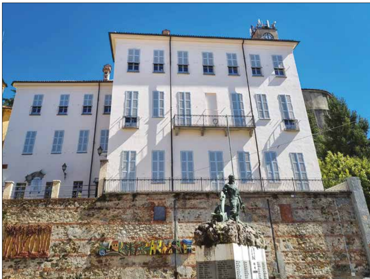
Palazzo Botton nel 2023 - facciata.
