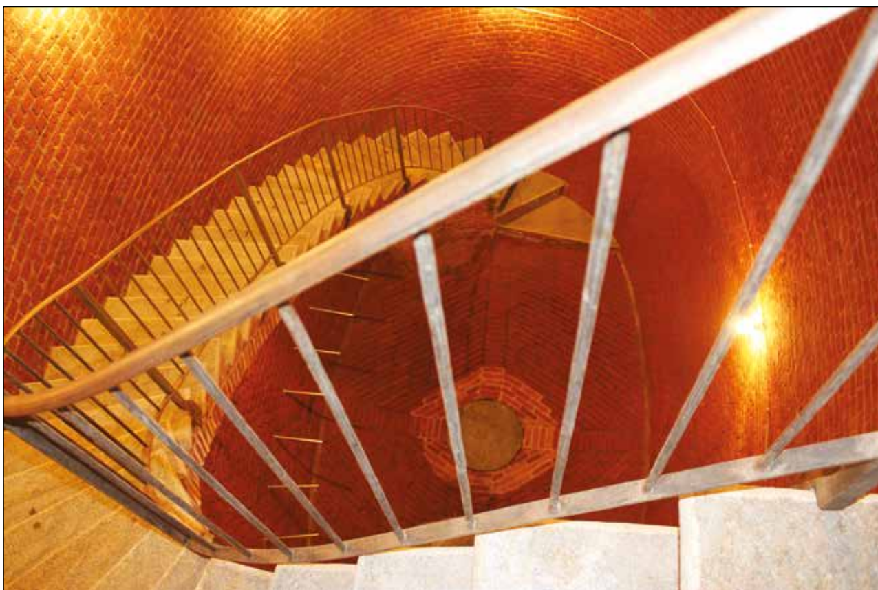
La ghiacciaia dopo i restauri del 2021.
